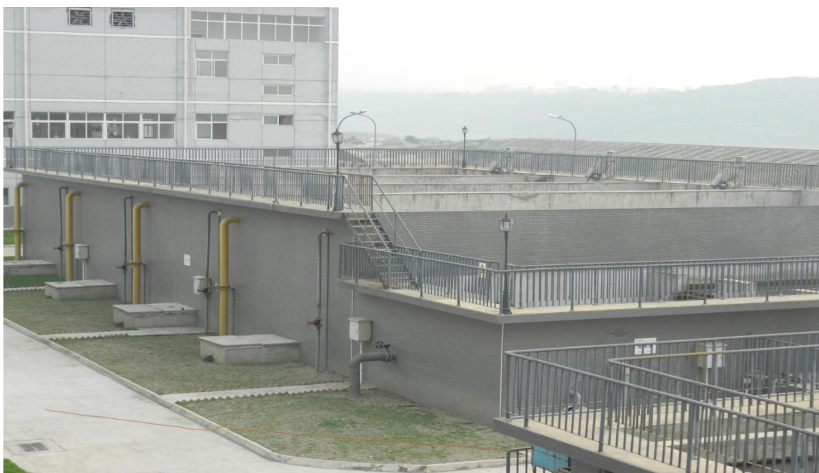
图 4-5 污水处理站 SBR、斜管沉淀池、清水池远景
