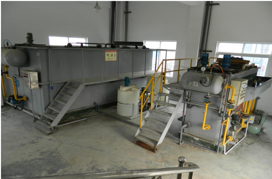
图 4-2 污水处理站气浮工序
