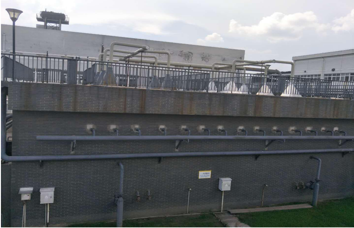
图 4-3 污水处理站 UASB 工序
