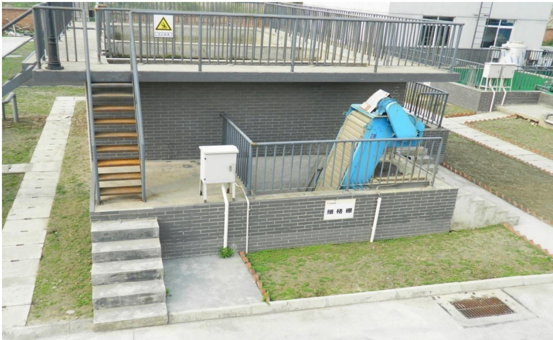
图 4-3 污水处理站隔栅和斜管沉淀池
