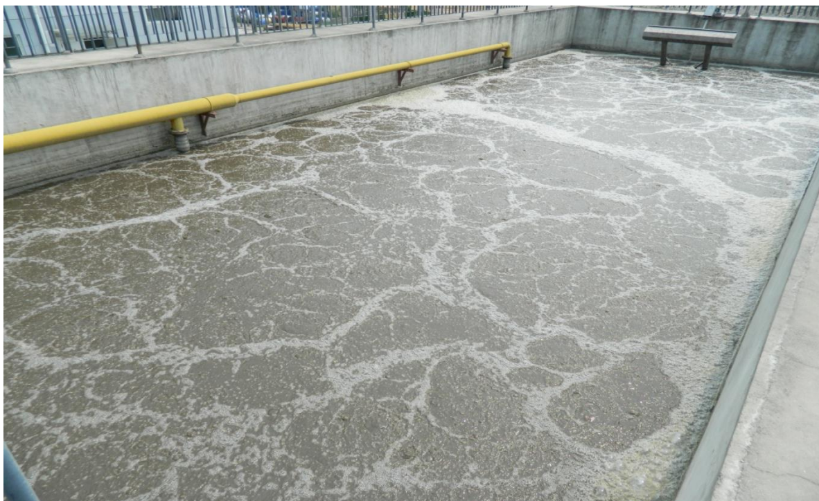
图 4-4 污水处理站 SBR 工序（曝气状态）
